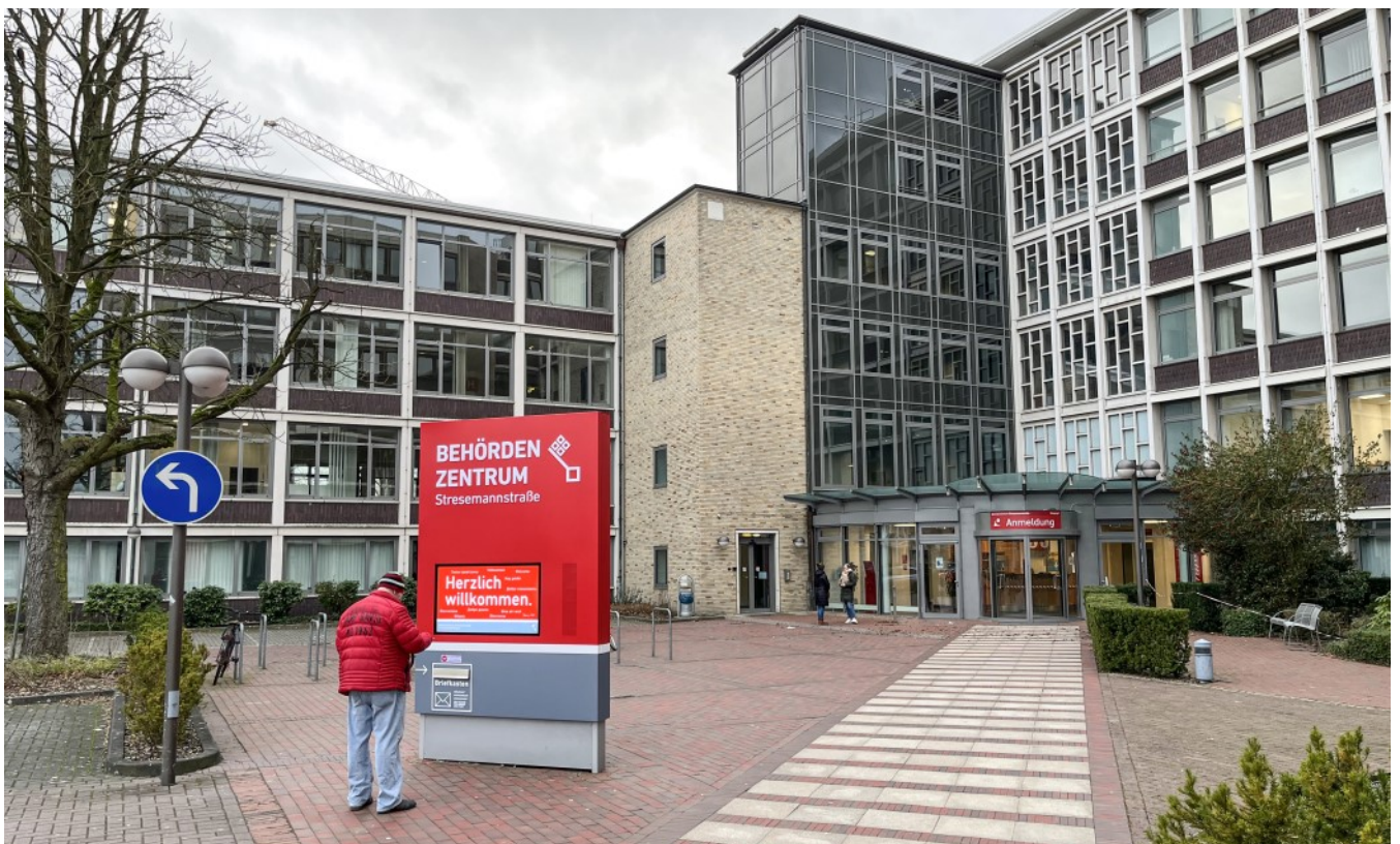
Außenbereich des Behördenzentrum Stresemannstraße mit neuem Leitsystem-Design
